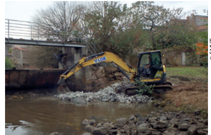
Apport et terrassement des matériaux (en haut) et rampe aménagée (en bas)
