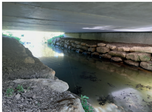
Banquettes semi-naturelles en terre/pierres/béton au rond-point de l'entrée de l'IUT de Niort. Deux ponts ont été équipés.
