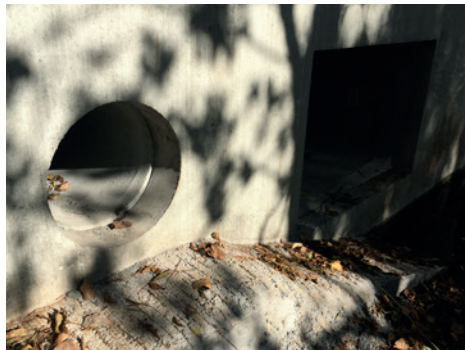
Busé sèche sous la chaussée de la RD 184 au Bourdet.
